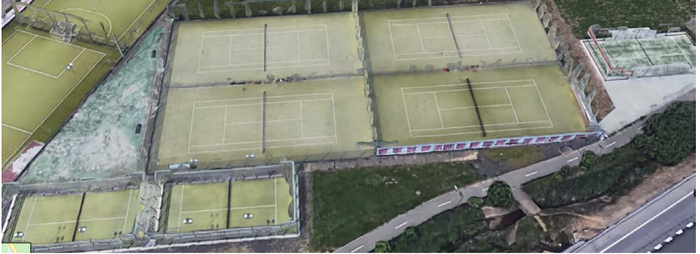
Pistas de tenis y pádel (Campus de Vegazana). Teléfono: 987291348 42.614337,-5.556971
